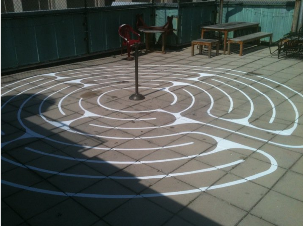
Phase 3: fill in lines with primer
